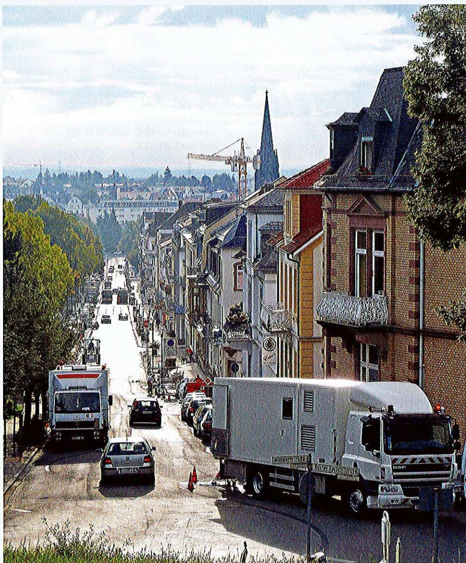
PARKSTRASSE: Die Kanäle werden mit GFK-Schlauchlinern saniert.
