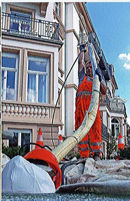
Einbau des Longliners in eine Gründerzeit-Villa Bild 7
