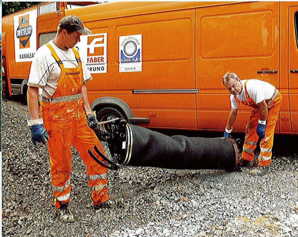
PACKER-SONDERKONSTRUKTION: für die Installation eines Longliners DN 800/600
