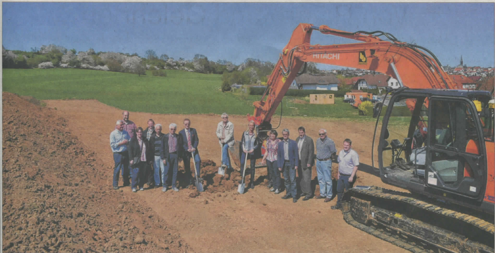
»Erster Spatenstich« für das Neubaugebiet »Baumgartenfeld III« am Rande von Grünberg.
