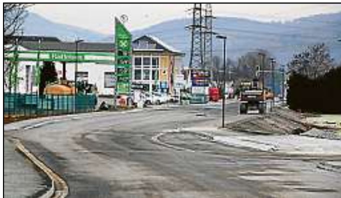
Die letzten Bagger sind gestern von der Straße abgezogen. Derzeit fehlt noch die Markierung. Diese kann allerdings bei Frost nicht aufgetragen werden.
