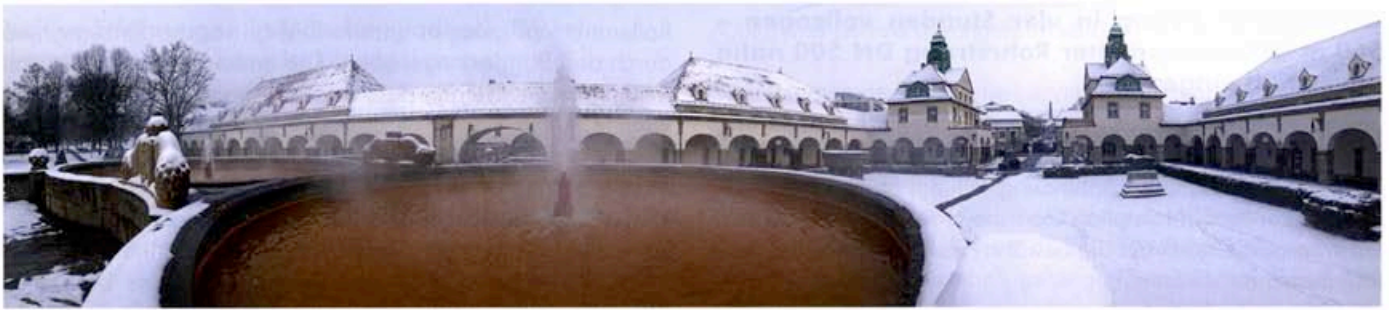
Jugendstil-Baudenkmal mit sanierungsbedürftiger Infrastruktur: Der Sprudelhof im Herzen Bad Nauheims.
