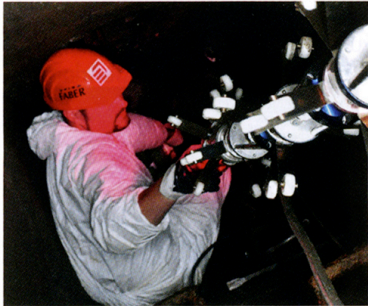
Lichterkeite zum Aushärten der GFK-Liner mit UV-Licht.
