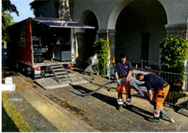
Vorbereitung des Packers für einen Longliner-Einbau in einen Hausanschluss.
