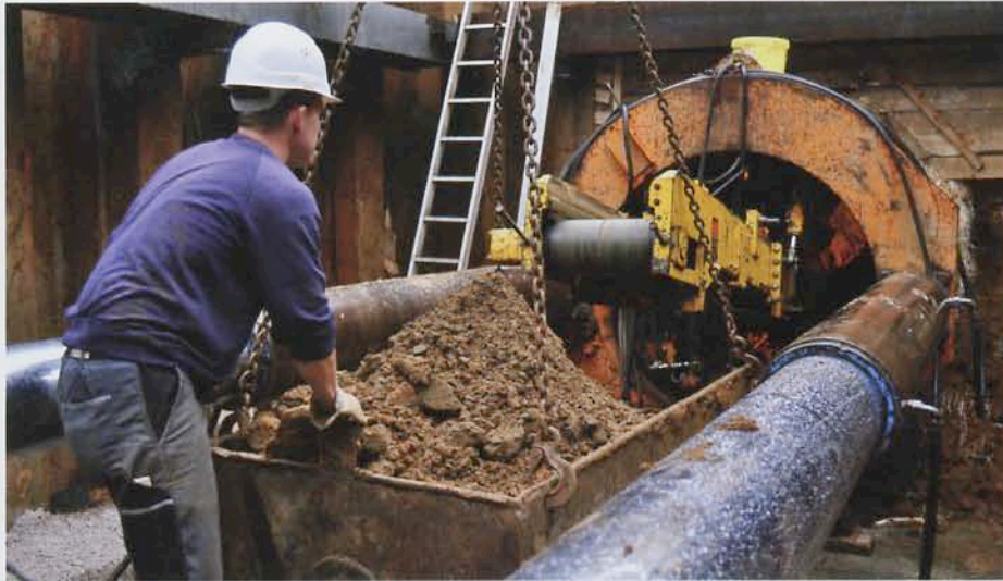
Das an der Ortsbrust abgebaute Erdreich wurde per Fließband kontinuierlich nach hinten gefördert.
