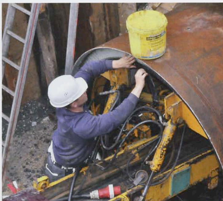
Einlegen eines Dichtungsringes vor Positionierung eines neuen Rohrs.
